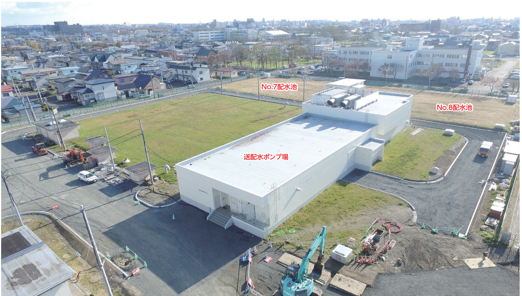
▲新送配水ポンプ場外観
