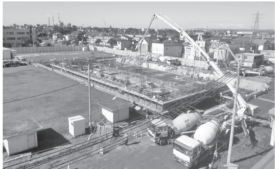
新送配水ポンプ場工事状況
