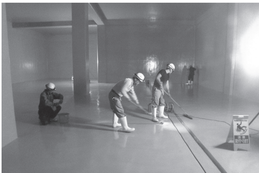
新配水池内部工事状況 [面積 1,500㎡×深さ4.5m×2池]
