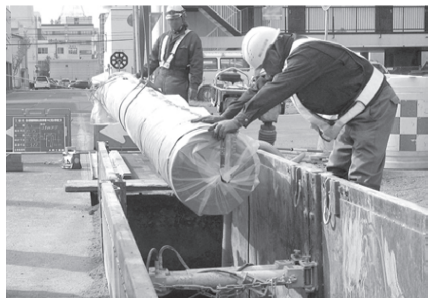
老朽管更新工事の様子
