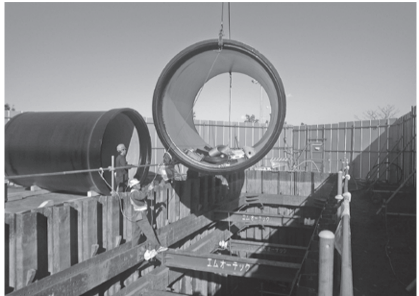
昭和地区緊急貯水槽建設工事
