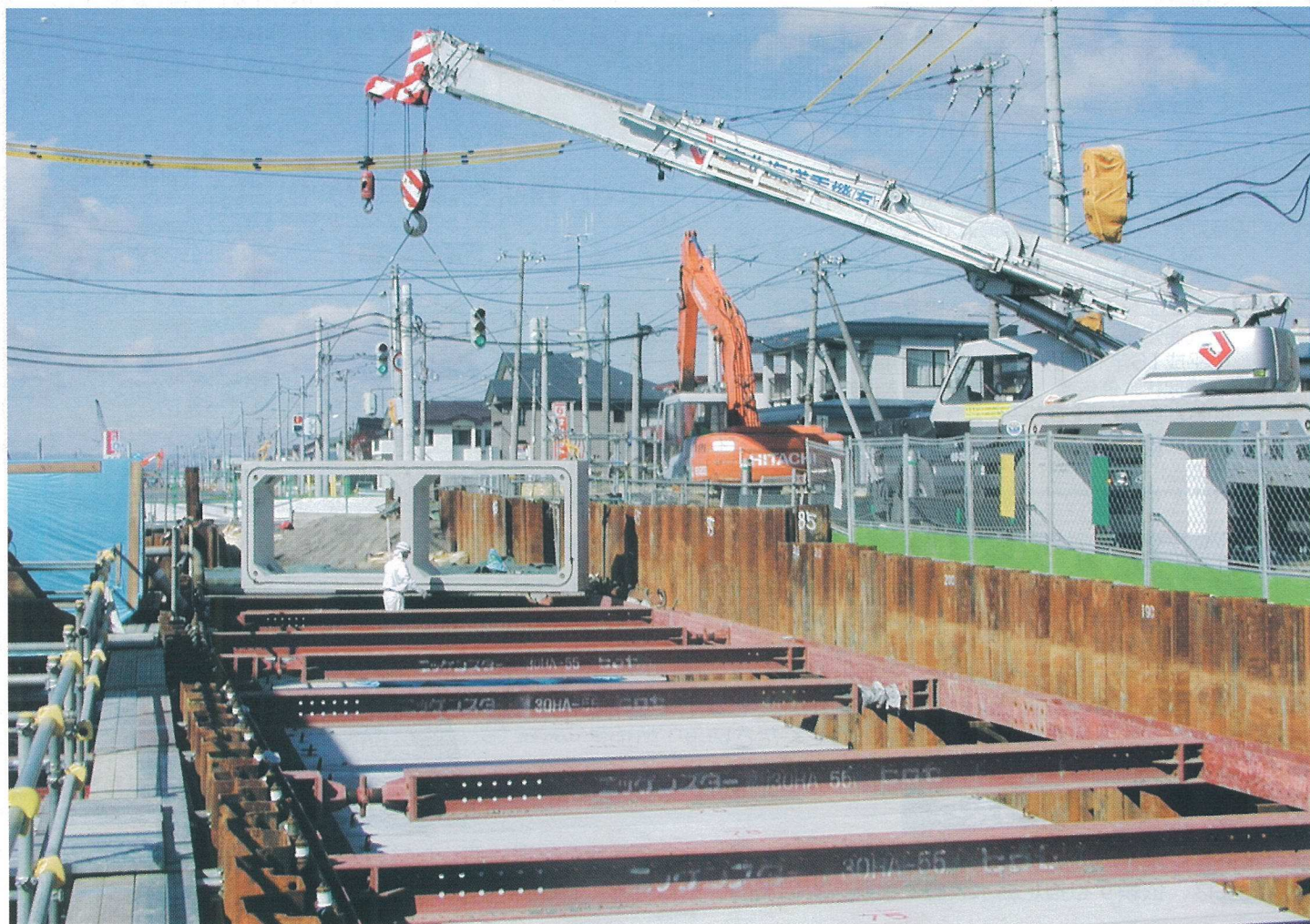
大楽毛処理区（50号幹線4工区）下水道築造工事
