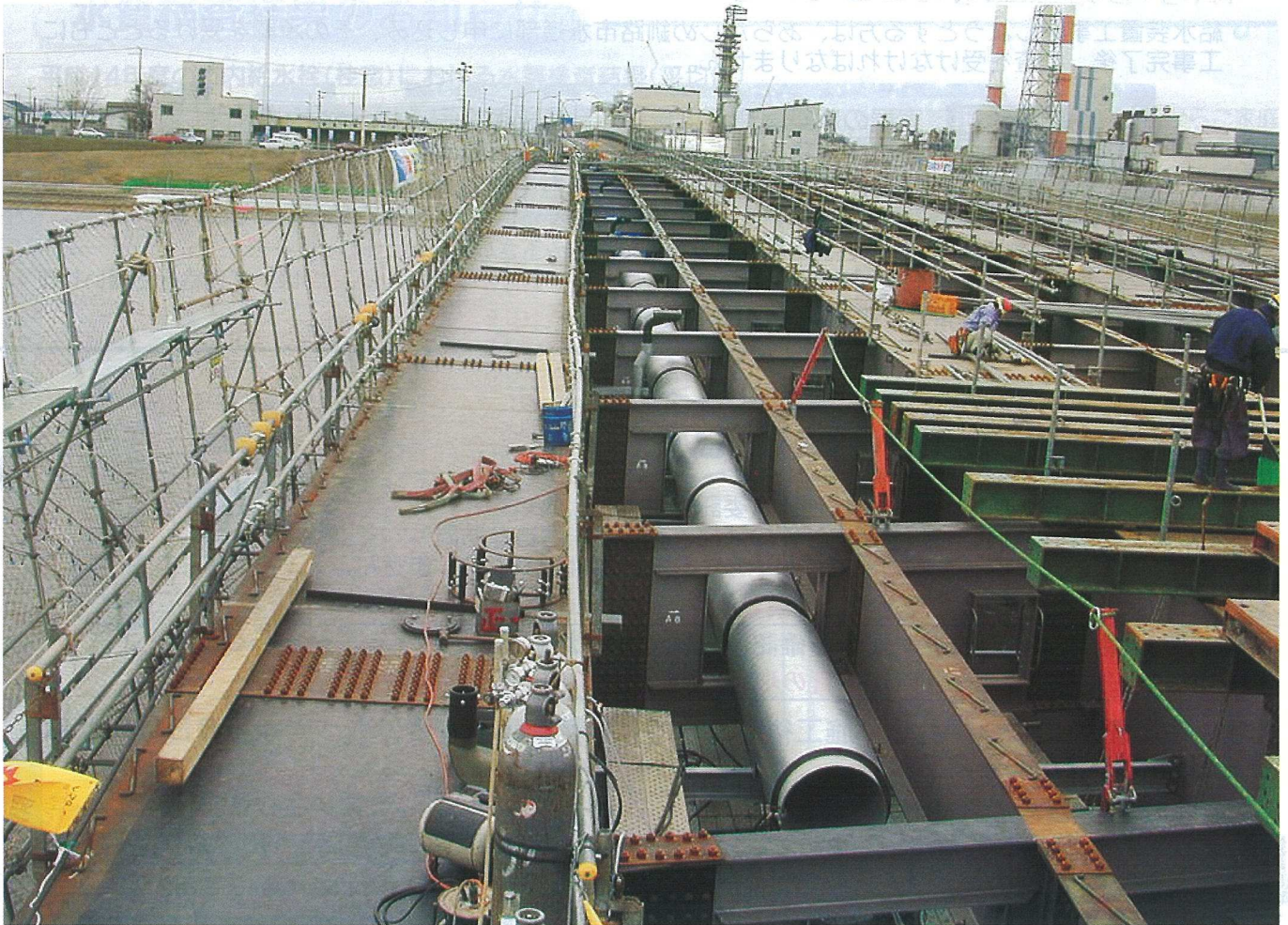
（鉄北大橋配水管添架 てんが 工事）
