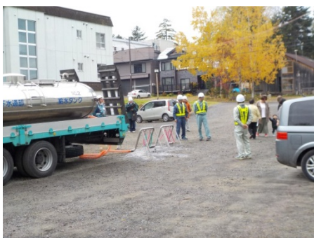
応急給水作業
