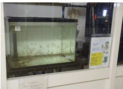
魚類による監視装置
