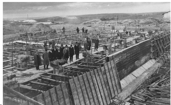
鶴ヶ岱浄水場建設（ろ過池築造 1925（大正 14）年）
