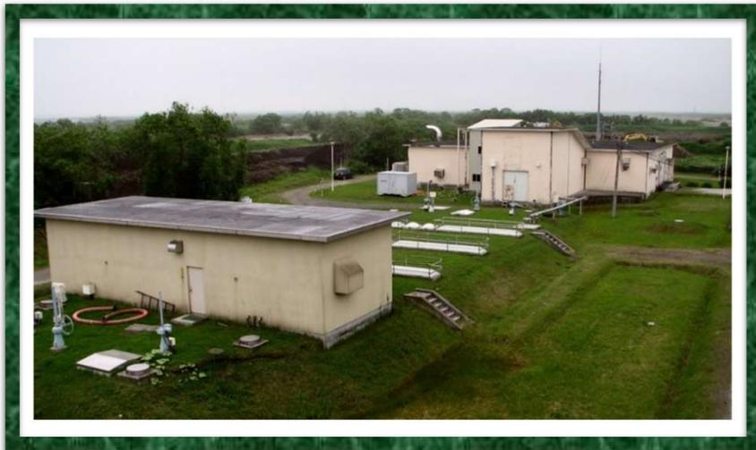
取水口から取り込んだ川の水は、導水ポンプ場に流れて来ます。流れてきた川の水は、砂等を沈めるための沈砂池と言う大きな池を通してから、ポンプと言う機械の力で愛国浄水場まで水を送っています。
