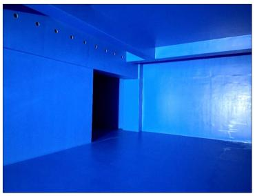
【地下1階】水処理後の水を貯える施設(浄水池)です。青色の防食防水塗装が施されています。
