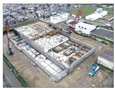
【全体写真】仮設鋼矢板の引抜作業、地下部分の 埋戻作業が完了しました。
