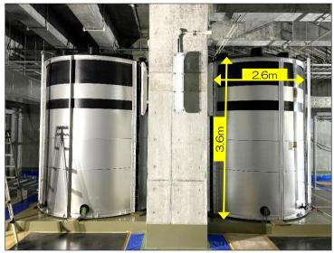
【地下2階】耐薬品塗装が施されたスペースに、 水処理に必要な薬品設備が搬入されました。
