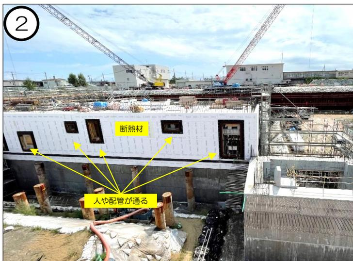
②方向からの写真です。白い部分は断熱材の施工状況です。黒枠部分は、人や配管が通る部分となっています。
