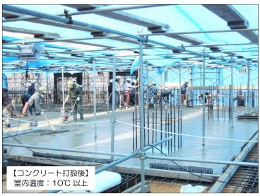
コンクリート打設時の状況です。風雪や低温など の気象の影響を受けないように仮囲い内で作業を 行っております。
