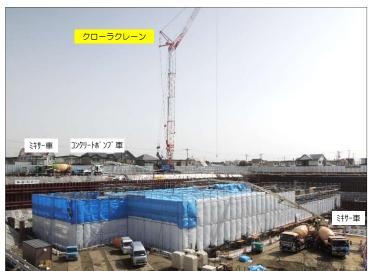
クローラクレーンは鉄筋や型枠などの資材を建物 内の施工場所に運ぶために使用されています。
