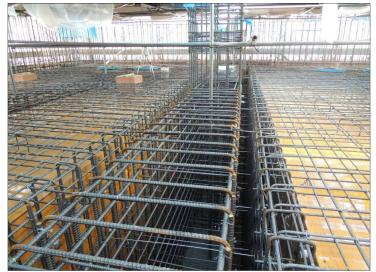
コンクリート打設前の雪寒仮囲い内の状況です。 設計基準に従い鉄筋と型枠が設置されております。
