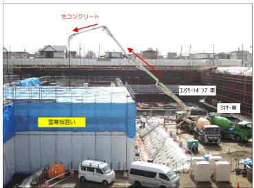
雪寒仮囲いは、コンクリート構造物の品質を確保 し、作業環境向上のために行われています。
