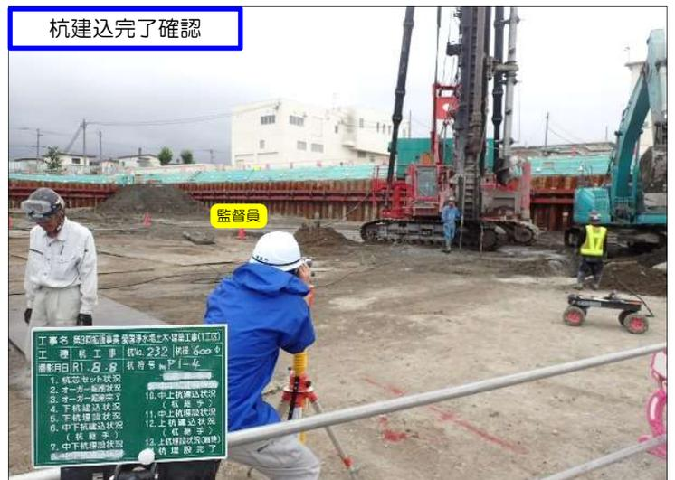
建込んだ杭が設計と通りの高さに設置されているかを最終確認します。
