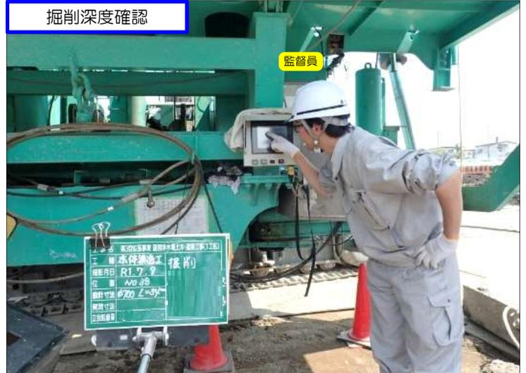
掘削深度が支持層に到達しているかを掘削機のモニタ画面で確認します。
