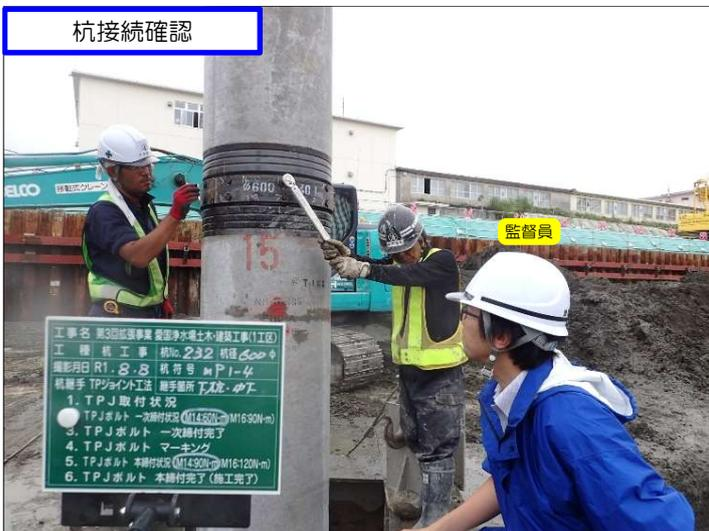
杭と杭を接合する部材が適正に施工されているかを確認します。
