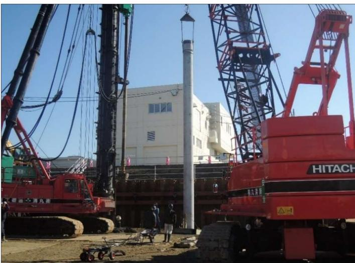
杭の建て込み状況です。掘削孔に杭を挿入し、杭と杭を接続しながら所定深度（支持層）に定着させます。
