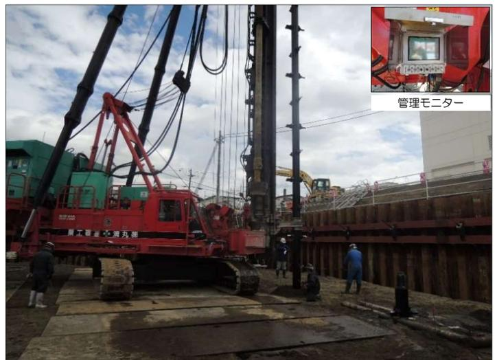
杭を建て込むための掘削状況です。掘削深度や掘削速度などの情報は全てモニターで管理できるようになっております。
