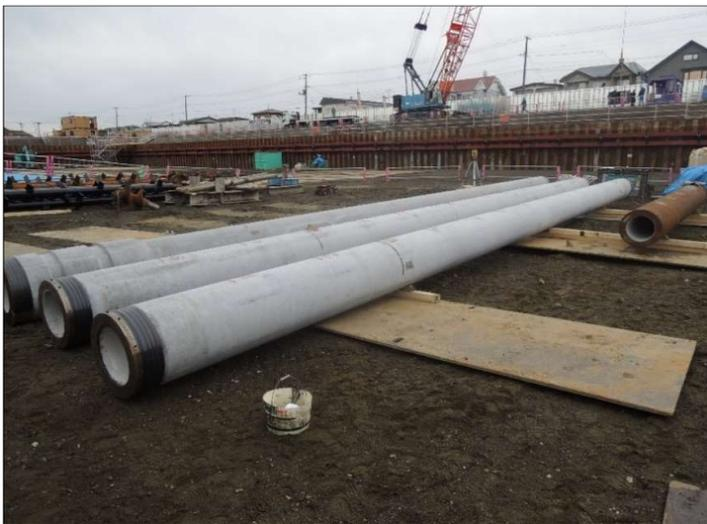
既製コンクリート杭です。1本6m～15mの杭を4～5本接続し、51m～64mの杭を296セット地中に建て込みます。
