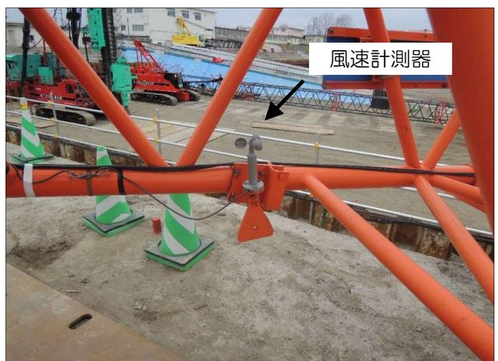
クレーンには風速を計測する計器が装着されており、作業の安全対策を施しています。
