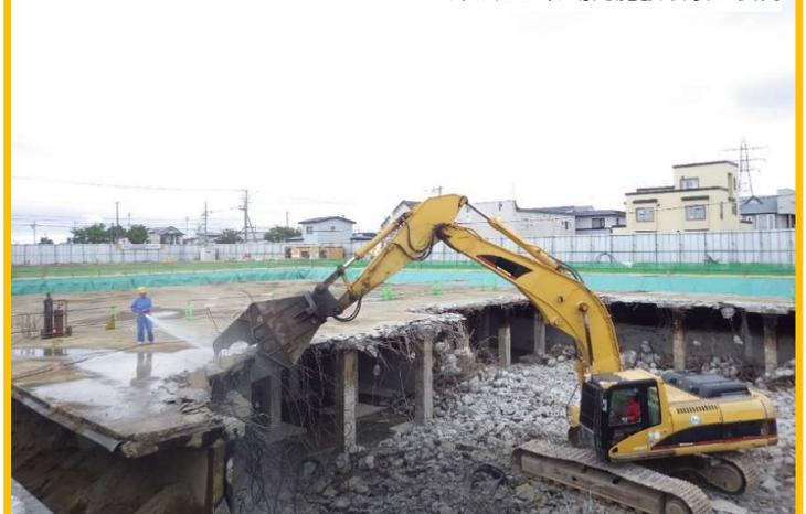
コンクリート圧砕機により挟み砕きながら、極力落下時等の衝撃音を抑制するように取壊します。
