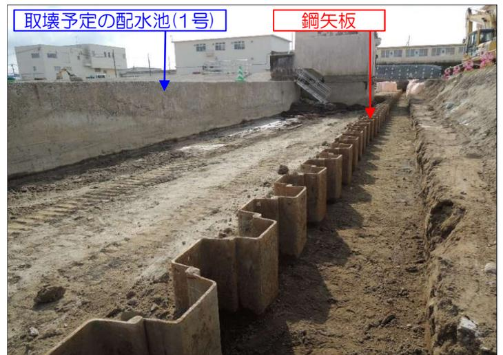
鋼矢板設置完了状況です。910枚の鋼矢板を設置しました。
