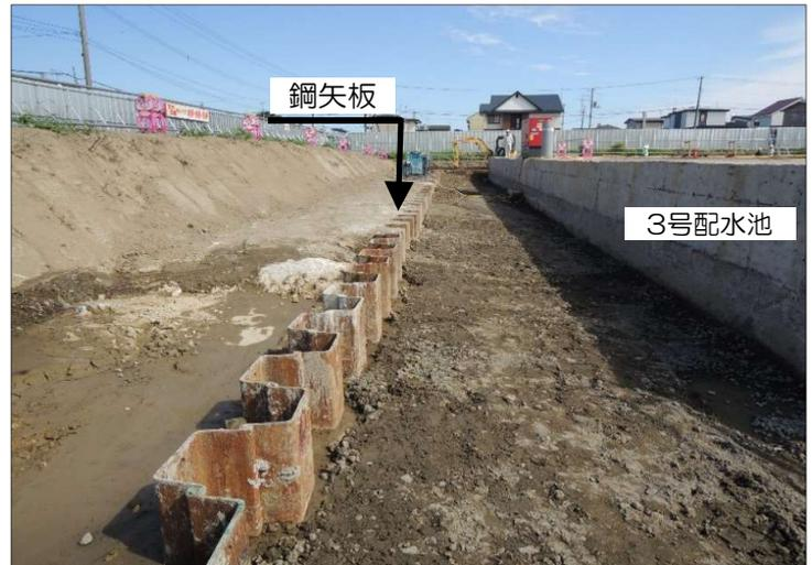
鋼矢板設置完了（北面）の状況です。地中に12m～22mの鋼矢板が設置されています。
