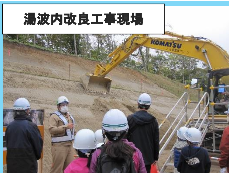
ICT施工説明
