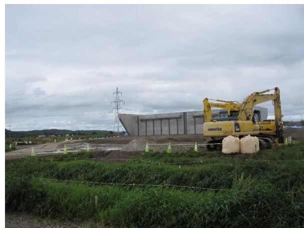
美濃改良工事現場
