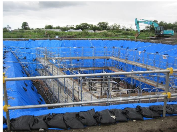
鶴丘橋A2橋台外一連工事現場
