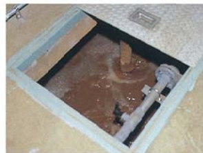
ばっ気槽 浄化機能をもったフロック状の微生物（活性汚泥）により、有機物質（BOD、SS）の処理を行います。
