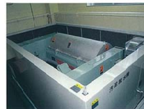
脱水機 浸出水処理の過程で発生する汚泥をベルトの圧力によって脱水し、脱水ケーキとされます。
