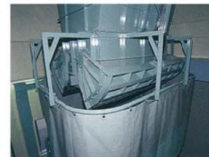
ケーキホッパ 脱水ケーキは一時、ホッパにて貯留され、トラックの圧力によって搬出されます。
