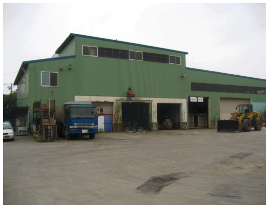
（粗大ごみ処理センター）
