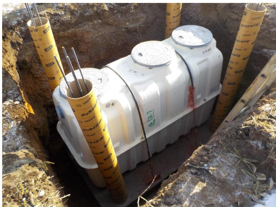
図 3-3-1 合併処理浄化槽（設置中の様子）
