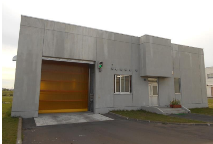
図 3-1-3 共同汚水処理施設
