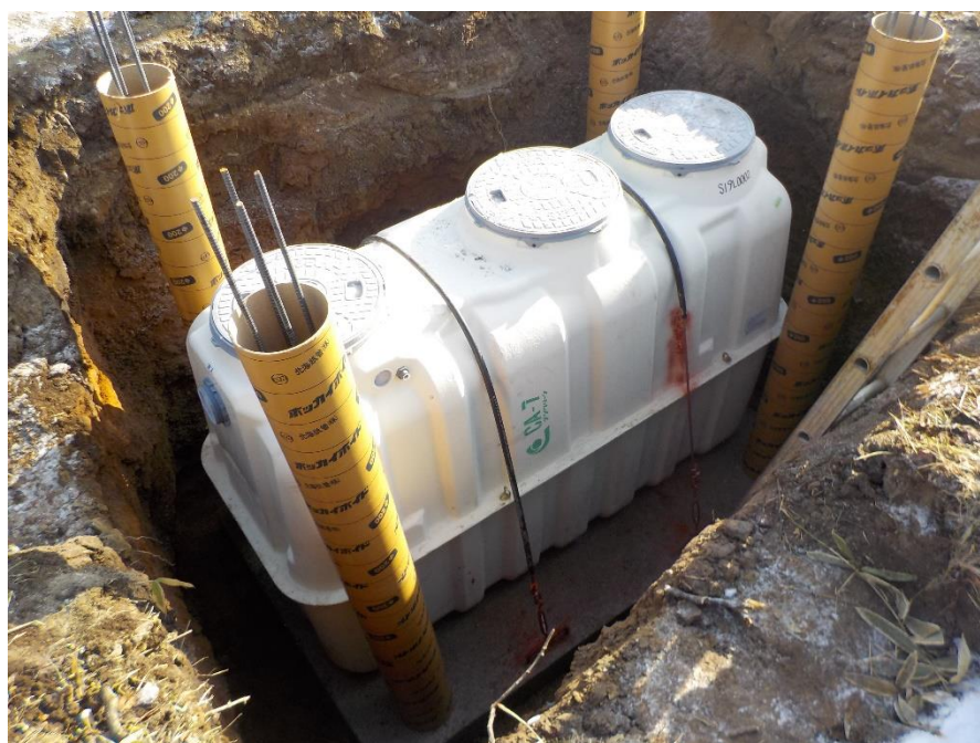
図 3-3-1 合併処理浄化槽（設置中の様子）
