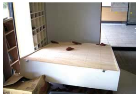
事例1: L字型金具で固定していましたが、金具が家具に付いたまま倒れています
