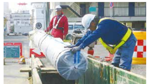
老朽管の更新
