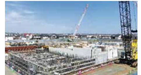
建設中の愛国浄水場 (22(令和4)年4月25日現在)
