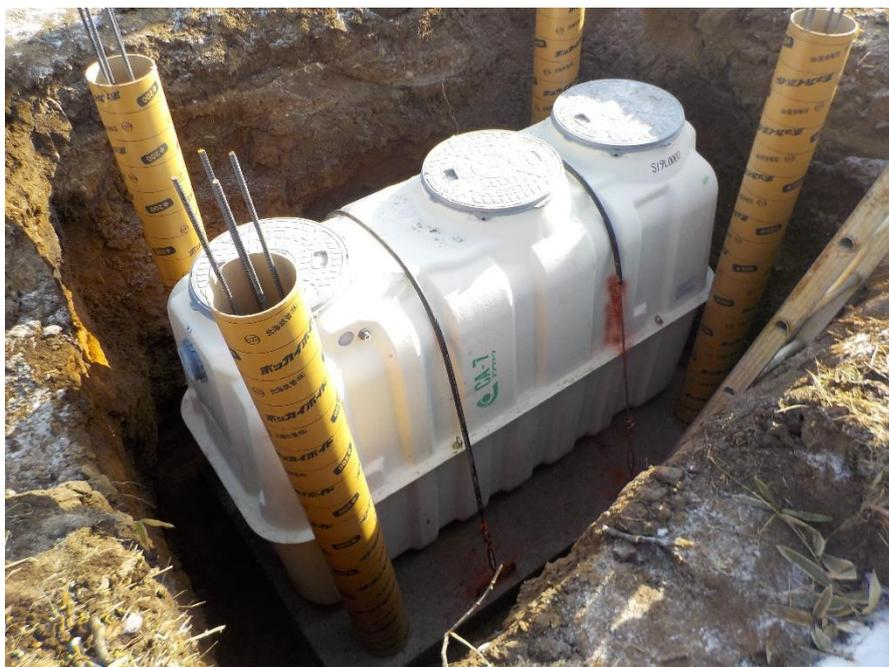
図 3-2-1 合併処理浄化槽（設置中の様子）
