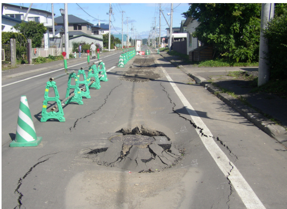
(平成 15年 十勝沖地震) 管路の浮き上がり等による陥没被害
