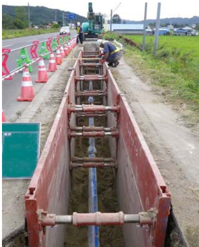
水道管施工状況
