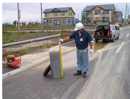
(2003年(平成15年)十勝沖地震) 液状化によるマンホール突出被害
