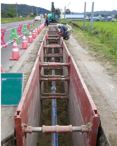
水道管路施工状況
