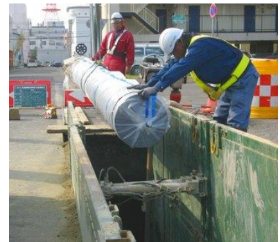
老朽管の更新
