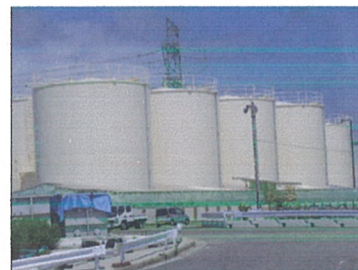
汚染水タンク
