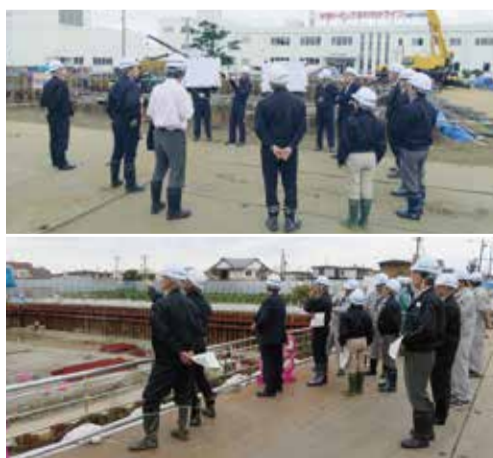
上:貯留槽建設現場 下:新愛国浄水場建設現場
