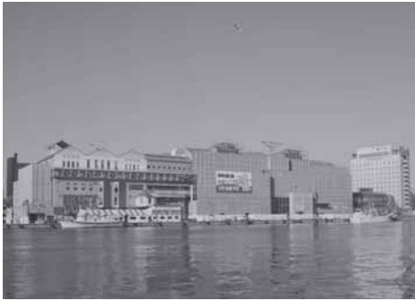
外壁改修工事が行われているMOO
