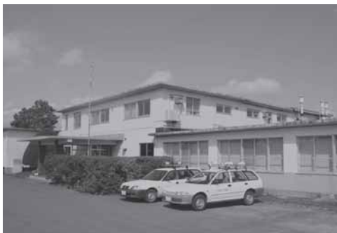
耐震対策が必要な愛国浄水場
