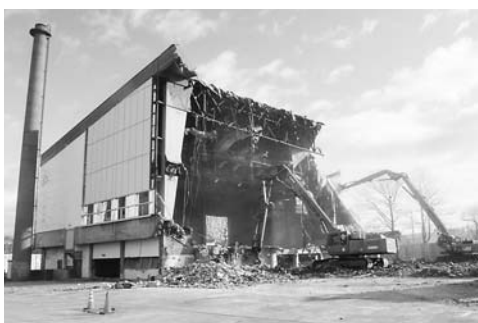
旧厚生年金体育館の解体作業
