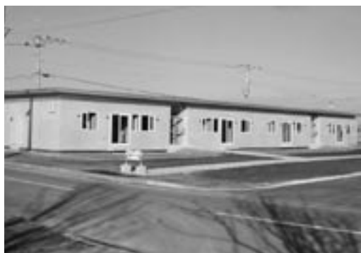
建替が進む海光公営住宅
