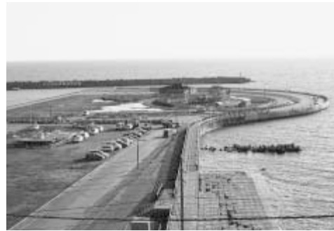
整備が進む千代ノ浦マリノパーク
