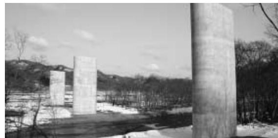
建設中の高速道路の橋脚
