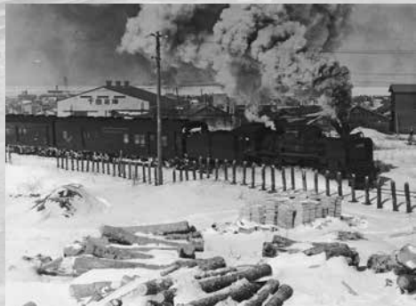
根室本線 根室駅 1970-3-3
