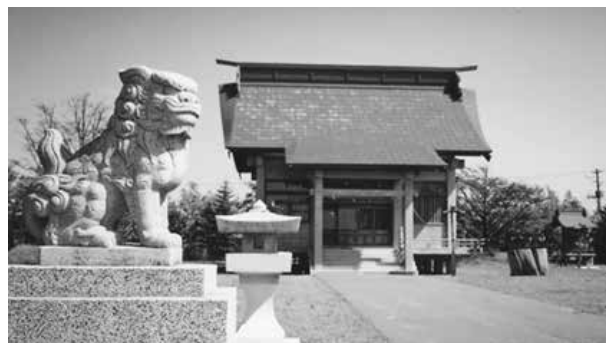
解体前の春採神社と稲荷大神(右奥) [青雲台]
