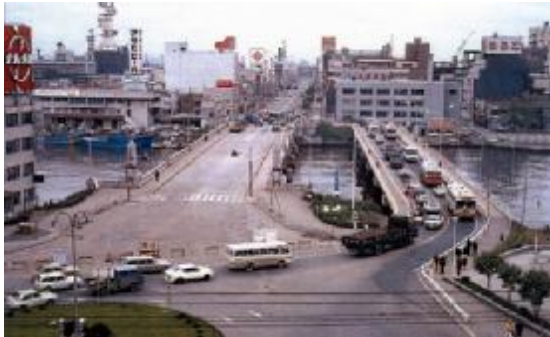
【翌年11月まで使われた仮橋と解体を待つ四代目幣舞橋】
