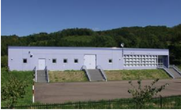
【音別簡易水道浄水場】
