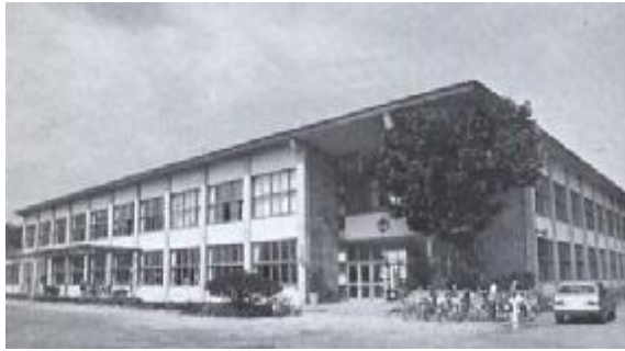
【鉄筋校舎になった阿寒小学校】
