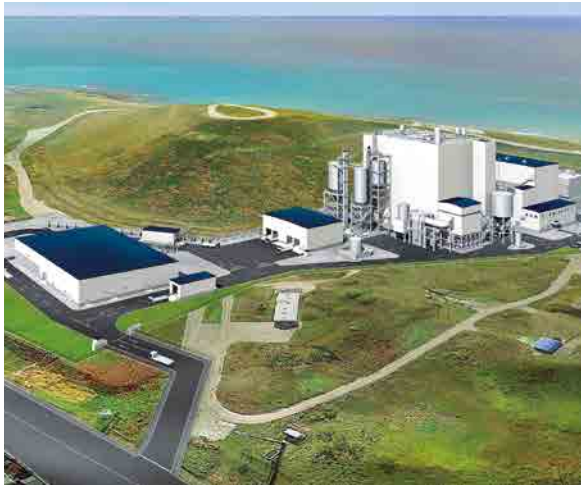
(株)釧路火力発電所(建設中)【石炭】【バイオマス】
