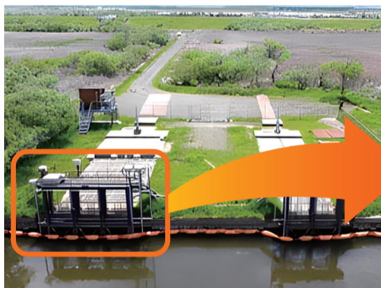
▲水を取り込む取水口
