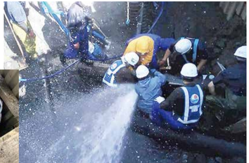
▲老朽管の破損
