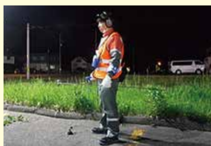
▲漏水調査の作業
