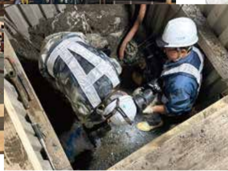
管の入れ替えの様子▶
