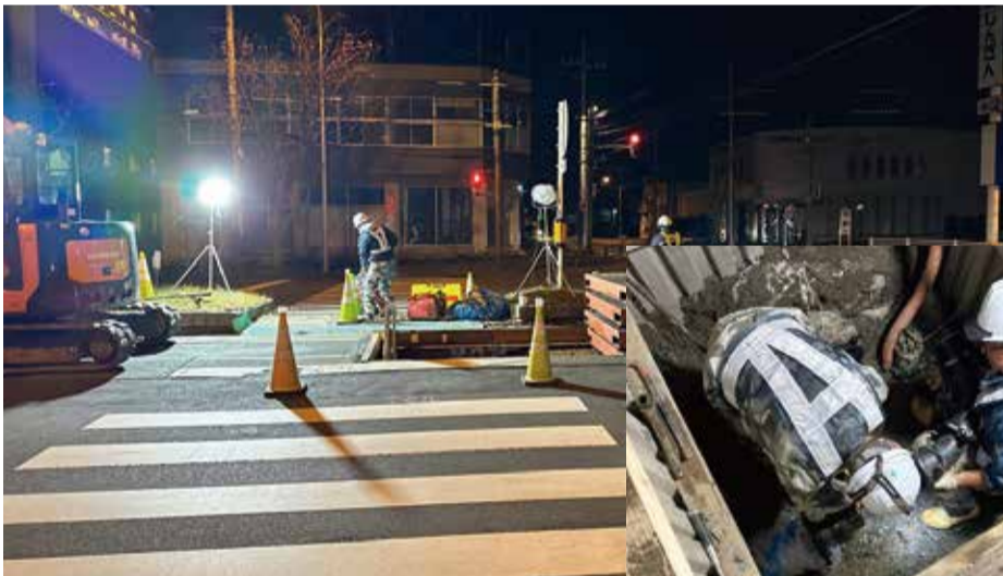
▲夜間作業の様子
