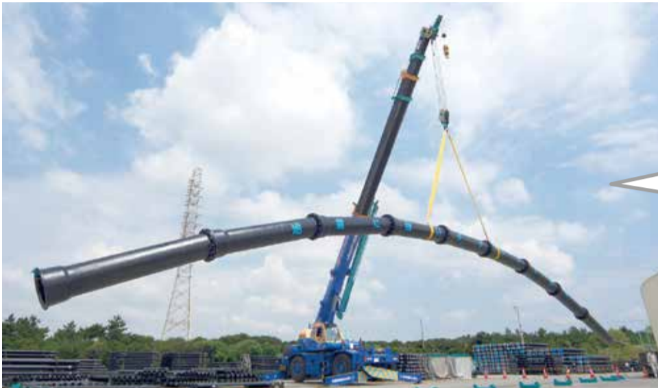
▲耐震化された水道管
