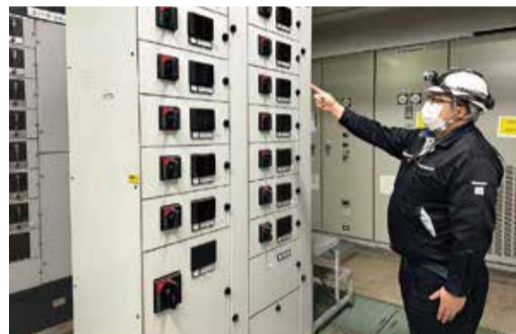
▲設備点検の様子
