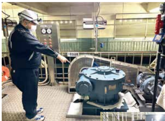
▲設備点検の様子
