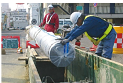
水道管の入替の様子
