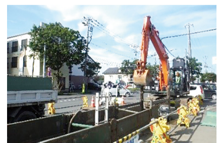
下水道管の入替の様子
