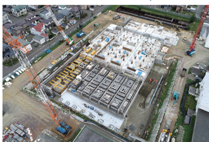
建設中の愛国浄水場の様子
