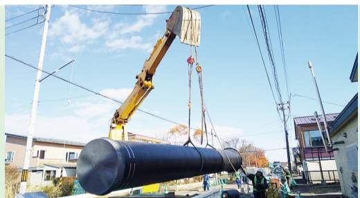
水道管工事の様子
