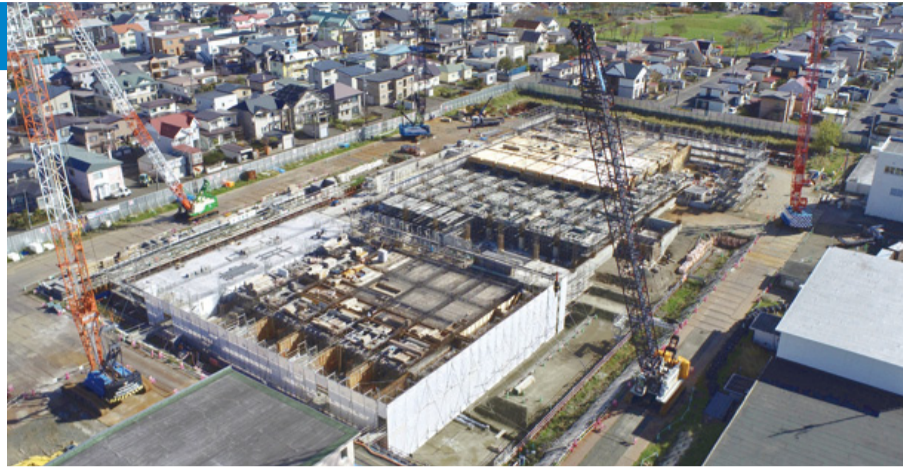
建設中の愛国浄水場
