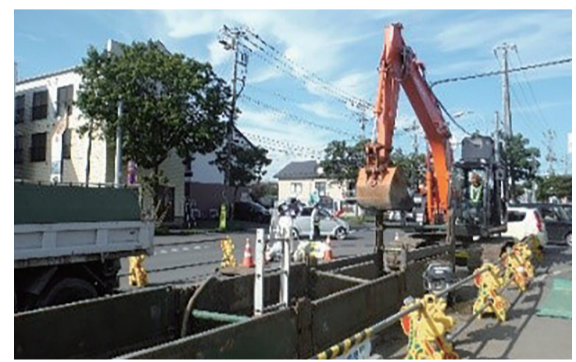
老朽管改築工事の様子
